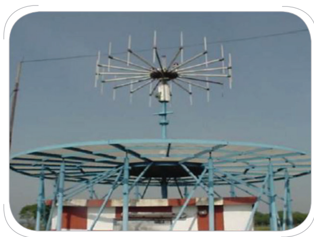
شکل ۲-۱۸ ایستگاه زمینی DF
