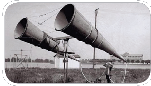
شکل ۳-۱۱ یکی از ابتدایی ترین ابزارهای تعیین حدودی موقعیت هواگرد
